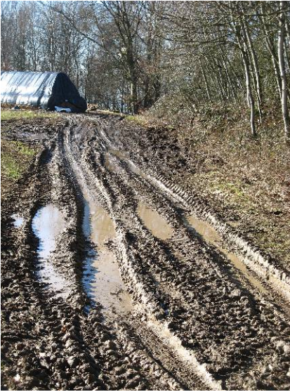
Abb. 15: Wegeschäden wie dieser sind durch Reitsport nicht zu erklären. (Foto: Dehe)
